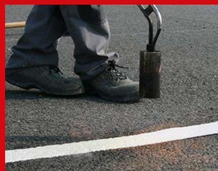
Termoplastické značení na asfalt a beton
